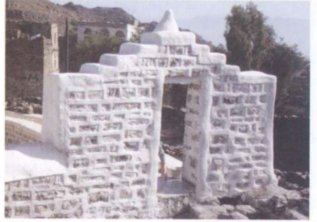
كتلة المدخل الجنوبي الغربي بعد أعمال الترميم
